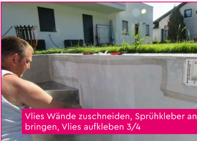
Vlies Wände zuschneiden, Sprühkleber anbringen, Vlies aufkleben 1/4
