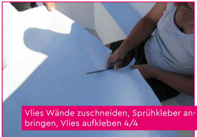
Vlies Wände zuschneiden, Sprühkleber anbringen, Vlies aufkleben 3/4
