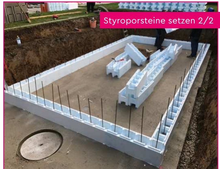
Styroporsteine setzen 1/2
