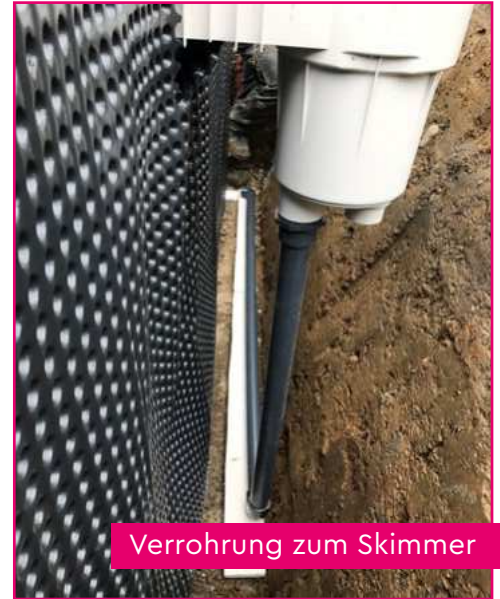
Noppenfolie an Außenseite und Verrohrung über Längsseite
