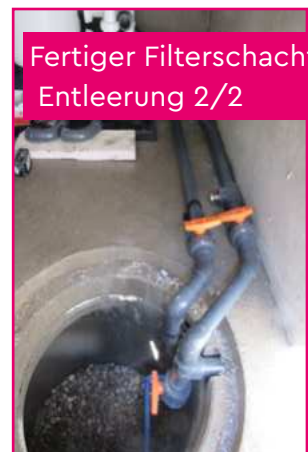
Fertiger Filterschacht mit Entleerung 1/2
