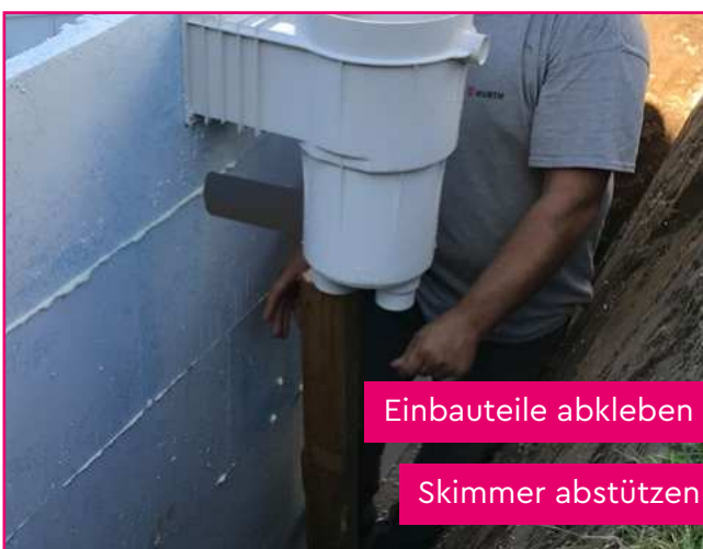
Skimmer ohne Flansch etwas vor die Wand setzen, sodass er später, wenn vernetzt und verspachtelt ist, bündig abschließt
