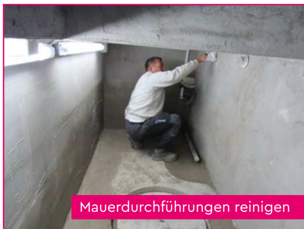
Fittinge reinigen vor Ankleben an Mauerdurchführungen
