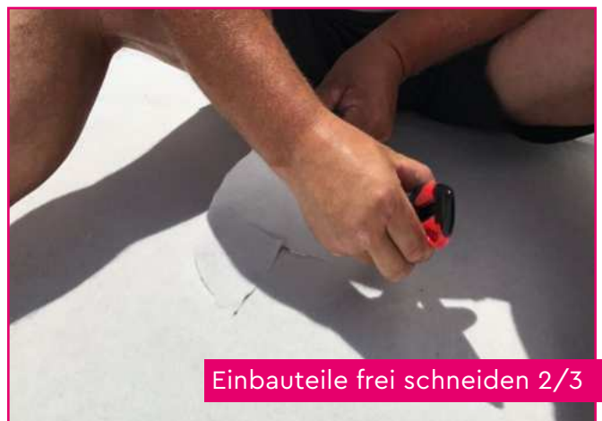
Einbauteile frei schneiden 1/3
