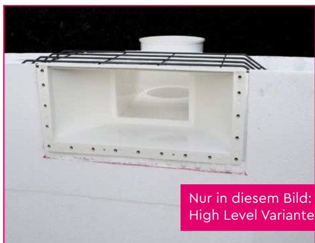
Einbauteile abkleben
