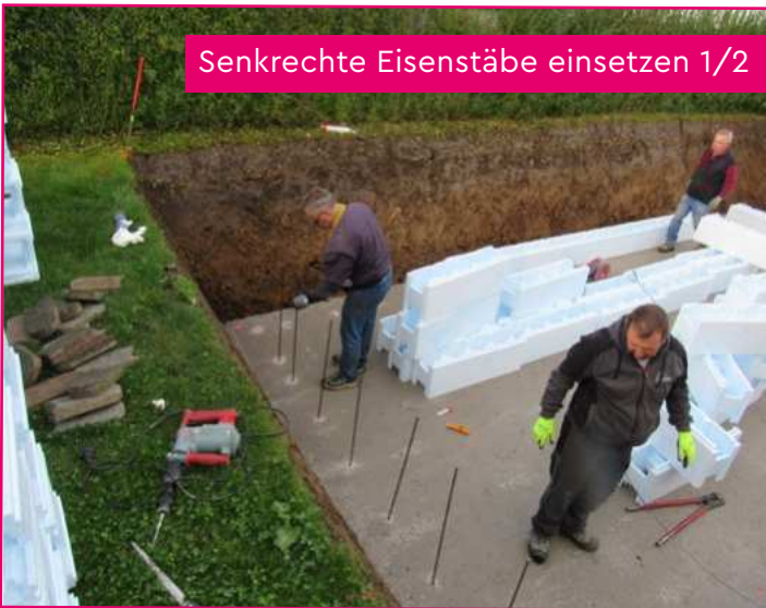
Styroporsteine setzen 1/2
