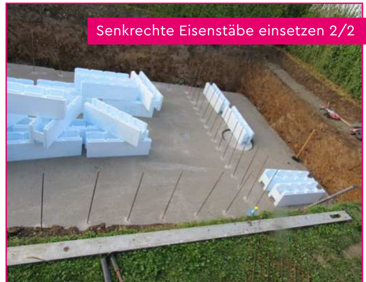
Styroporsteine setzen 2/2
