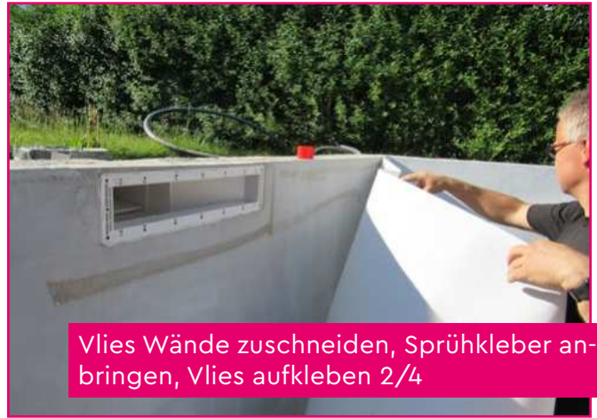
Vlies Wände zuschneiden, Sprühkleber anbringen, Vlies aufkleben 1/4
